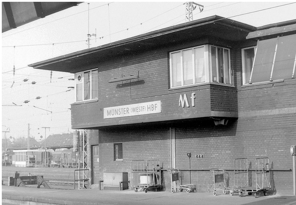
Das alte Befehlsstellwerk „Mf“ war bis 1985 in Betrieb
